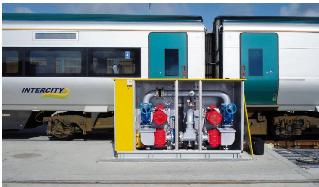
Рисунок 2. Устройство для откачки сточных вод из резервуаров на железнодорожных станциях
